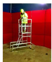
11) FIT GUARDRAIL BRACES AT FRONT AND BACK OF UNIT
